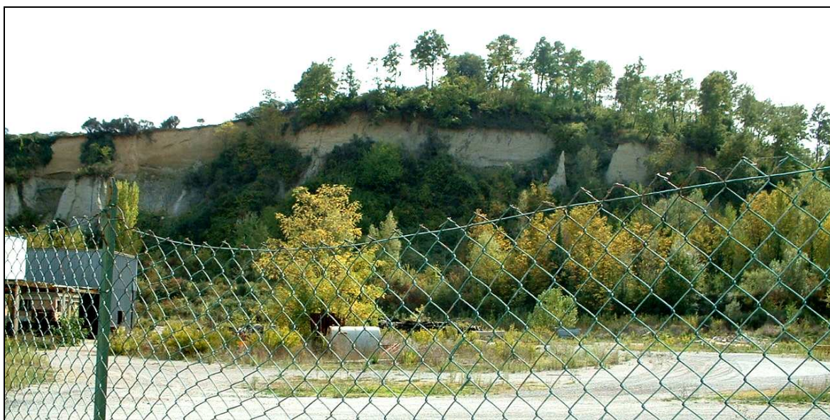
Foto 4: esempio di scarpata in degradazione (Fornace di Montorio).
